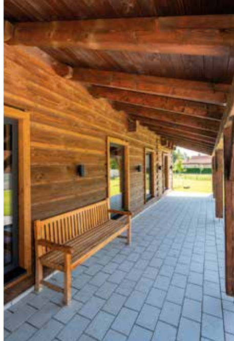
Krytá terasa chrání dům z jižní strany proti přehřívání interiéru. I během opravdu horkých dní je tak uvnitř příjemné klima
